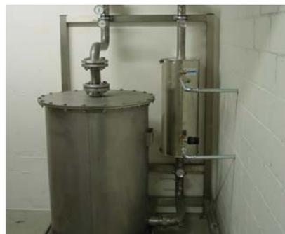
Die Siloxanlage mit Aktivkohle absorbiert die Siloxane aus dem Klärgas, um die Verbrennungsmotoren vor dem glasharten Belag im Verbrennungsraum zu schützen (Siliziumdioxid). Vorzeitiger Verschleiss und teure Reparaturen können vermieden werden, Standzeiten werden verlängert.
