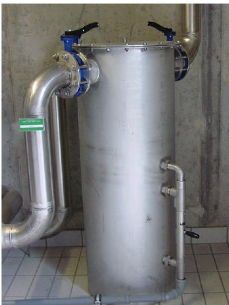
Je nach Anwendung, individuellen Bedürfnissen und Konzeption der Anlage, können die Kondensatschleusen für einen automatisierten Betrieb mit pneumatischen oder EX-geschützten, elektrischen Antrieben ausgerüstet werden. Wir liefern auch passende Niveau-Geber (unten rechts), visuelle Niveau-Anzeigen (oben links) und Anschlusszubehör (Steuerung / Programmierung bauseitig).
