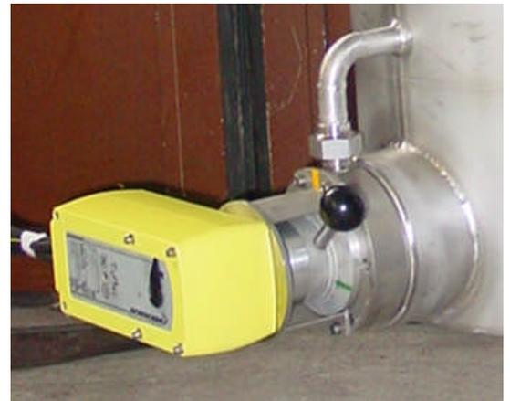
Die DI-TEC-Kondensatschleusen wurden DVGW-geprüft (DIN EN 161 01.08.1996, Prüfung 2009) und lassen sich zum Entwässern von Leitungen an Tiefpunkten (Bild unten rechts), in Kombination mit verschiedenen Sammelbehältern, an Kiesfiltern (Bild unten links) und unzähligen weiteren Anwendungen einsetzen.
